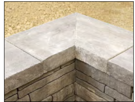
Diagram 11—45-degree miter
